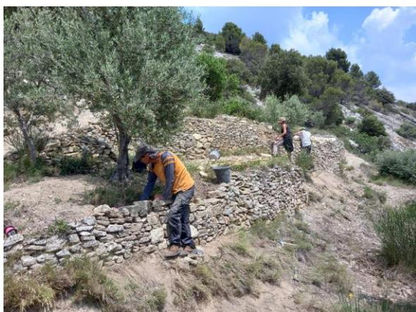
Figure 1 : Chantier de restauration sur ouvrage de soutènement. Beaumes-de-Venise (Vaucluse) 2023 (© L. Cagin).
